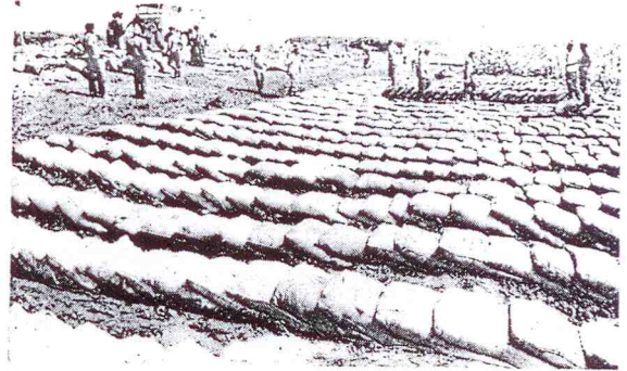
● Az átázott és tellazult töltésszakaszon, a mentett oldalon bordás homokzsák terheléssel szorítják ki a gátból a vizet.
