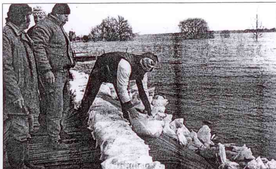
Tiszaögnél homokzsákokkal, földdel és nádlapokkal erősítik a védműveket.
