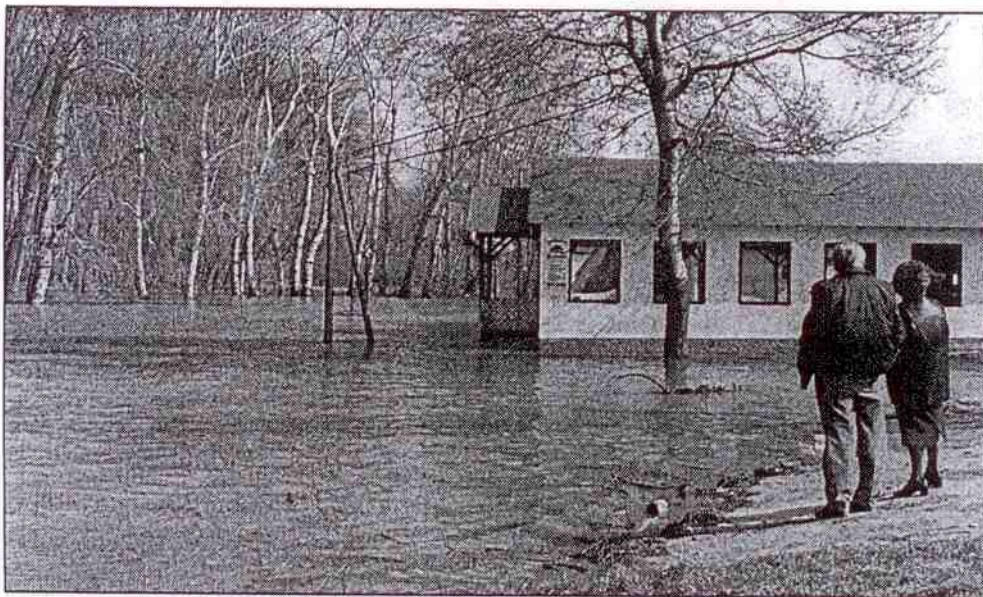
Kécskén a Tisza-parti diszkó épületét nyaldossa az árvíz.
