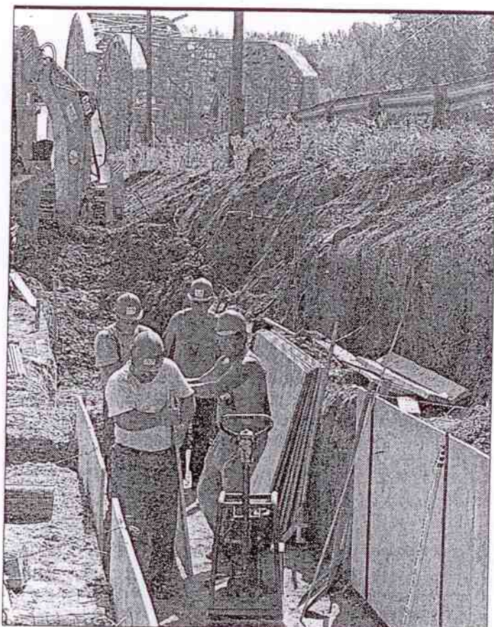
ÚJRAINDULT A HÍDÉPÍTÉS. A hét elején ismét folytatták a tiszai közúti híd építését. A magas vízállás miatt a munkálatokat egyelőre csak a Kecskemét felé eső oldalon végzik. A hídépitők jelenleg a vasbeton szerkezeteket szerelik.
