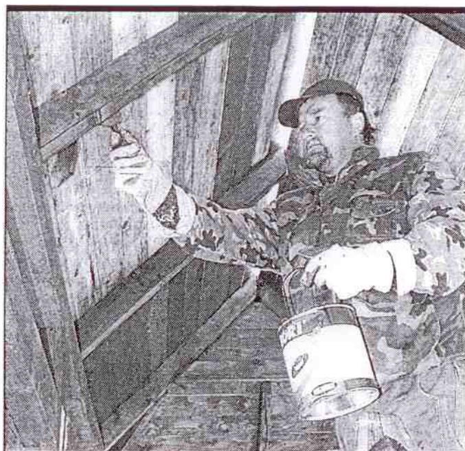
ÚJ BUSZMEGÁLLÓK. A lakiteleki önkormányzat három új buszvárót létesít a 44-es számú főúton. Az elsőt Kapásfalunál állították fel, ennek munkálatait örökítette meg felvételünk.
